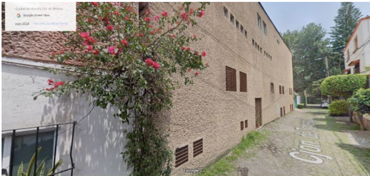
Figura 25. Centro de la obra en el Callejón Torresqui, Barrio de Santa Catarina, CDMX cerca de los Viveros de Coyoacán. Fuente: Google Street View (2024). Google Maps. Recuperado de https://www.google.com.mx/maps/ el 01/05/2025.
