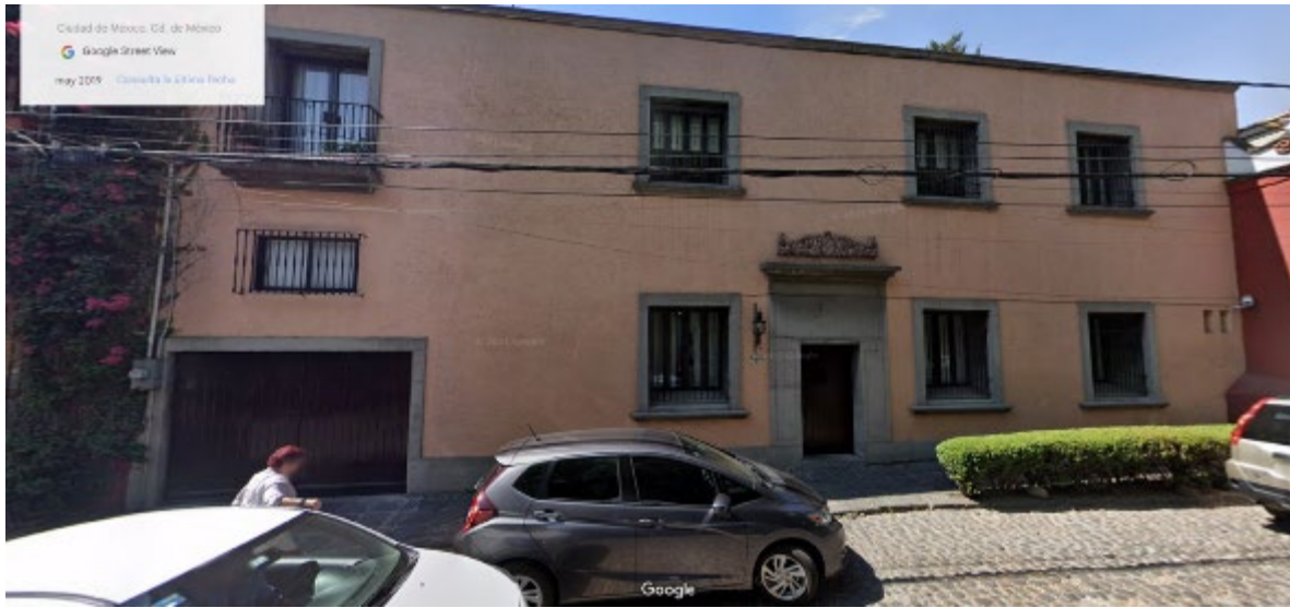
Figura 24. Centro de la obra en Frontera 30, San Ángel, CDMX. Fuente: Google Street View (2019). Google Maps. Recuperado de https://www.google.com.mx/maps/ el 01/05/2025.
