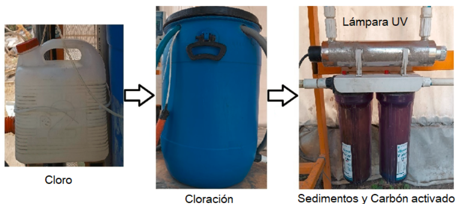
Figura 3.4: Sistema de tratamiento de agua pluvial.
