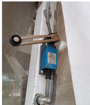
(a) Sensor de final de carrera.
