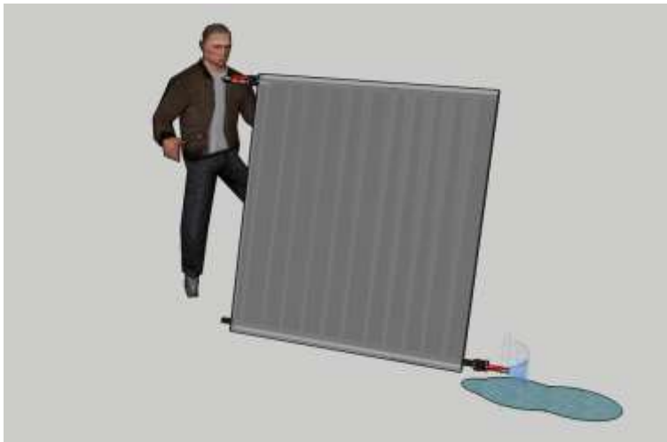
Figura 19. Drenado de agua del colector solar
