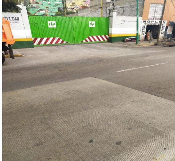
Imagen propia-. Predio de construcción del Cablebús ubicado en la Avenida Puerto de Mazatlán
