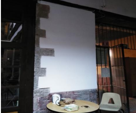
Figura 49 correspondiente a la zona restaurada en la segunda fase de restauración que se encuentra en la calle República del Salvador en la planta baja del inmueble. Fuente perteneciente al archivo fotográfico de Jessica Mendoza (2021).
