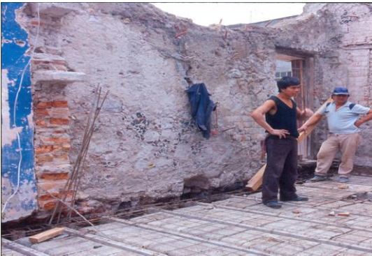
Figura 35 se puede observar cómo se está cambiando el piso de la planta alta. Fuente perteneciente al archivo fotográfico de Gilda Cano (1987).
