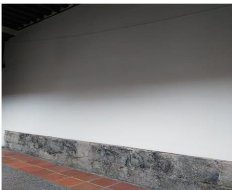
Figura 48 correspondiente a la zona restaurada en la segunda fase de restauración que se encuentra en la calle República del Salvador en la planta baja de la Casa. Fuente perteneciente al archivo fotográfico de Jessica Mendoza (2021).
