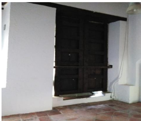
Figura 53 correspondiente a la zona restaurada en la segunda fase de restauración correspondiente al salón que se encuentra en el segundo patio de la Casa. Fuente perteneciente al archivo fotográfico de Jessica Mendoza (2021).
