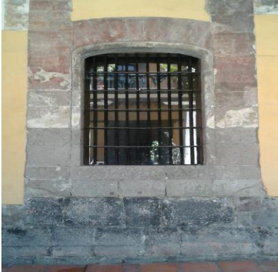
Figura 12 correspondiente a una de las ventanas de Casa Talavera. Ubicada en el interior del primer patio. Fuente perteneciente al archivo fotográfico Jessica Mendoza (2020).
