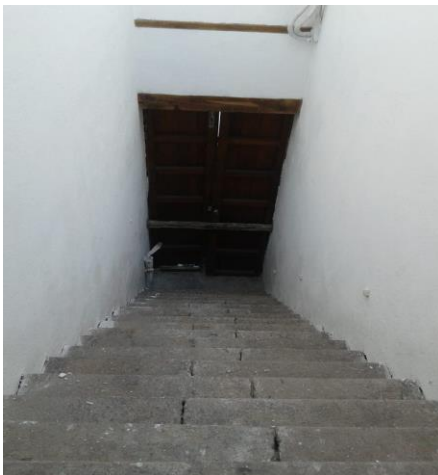
Figura 20 correspondiente a uno de los accesos de cuando la Casa fue ocupada como Casa Habitación. Las escaleras están hechas de reolita. Fuente perteneciente al archivo fotográfico de Jessica Mendoza (2020).
