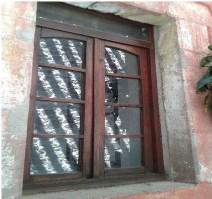
Figura 25 correspondiente de una de las ventanas de Casa Talavera de la planta alta, la cual no es original, pero conserva el contorno hecho de chiluca. Fuente perteneciente al archivo fotográfico de Jessica Mendoza (2020).
