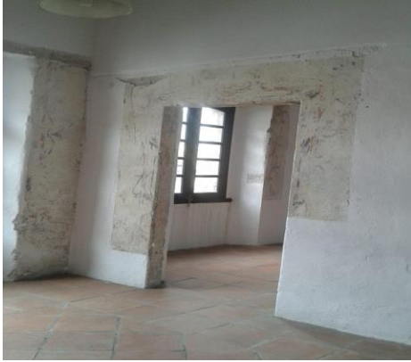
Figura 38 correspondiente a la zona que fue restaurada en la primera fase. Se puede ver como se siguen conservando “las cenefas” que hay en Casa Talavera. Fuente perteneciente al archivo fotográfico de Jessica Mendoza (2020).
