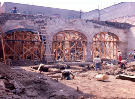
Figura 36 se puede ver como se está trabajando en el segundo patio y en la zona conocida como “pecera”. Fuente perteneciente al archivo fotográfico de Gilda Cano (1987).
