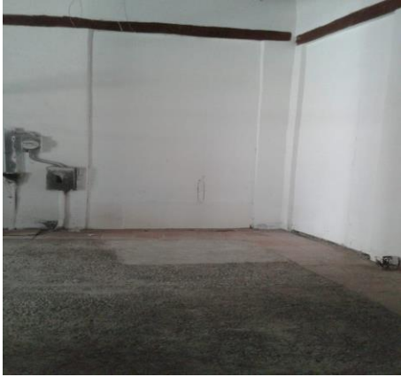
Figura 46 correspondiente a la zona restaurada, dicho lugar se encuentra en la calle República del Salvador. Fuente perteneciente al archivo fotográfico de Jessica Mendoza (2020).
