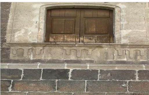
Figura 28 correspondiente a la guardamalleta que se encuentra en la fachada principal de Casa Talavera. Fuente perteneciente al archivo fotográfico de Jessica Mendoza (2020).
