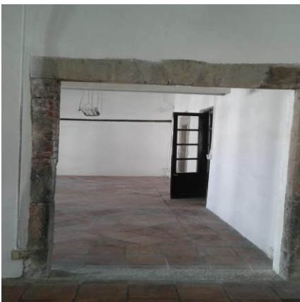
Figura 21 correspondiente al contorno original cuyo material es de chiluca se encuentra en la zona que anteriormente ocupaba administración de la UACM. Fuente perteneciente al archivo fotográfico de Jessica Mendoza (2020).
