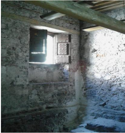
Figura 6 correspondiente a una de las ventanas originales que tiene Casa Talavera ubicada en la zona donde se encuentra la ventana arqueológica. Fuente perteneciente al archivo fotográfico de Jessica Mendoza (2020).
