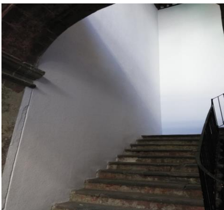
Figura 54 correspondiente a la zona restaurada en la segunda fase de restauración correspondiente a los muros que están en las escaleras del primer patio de la Casa. Fuente perteneciente al archivo fotográfico de Jessica Mendoza (2021).
