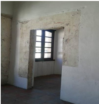
Figura 30 correspondiente a las “cenefas” que conserva Casa Talavera, ubicadas en la planta alta en la zona de República del Salvador. Fuente perteneciente al archivo fotográfico de Jessica Mendoza (2020).
