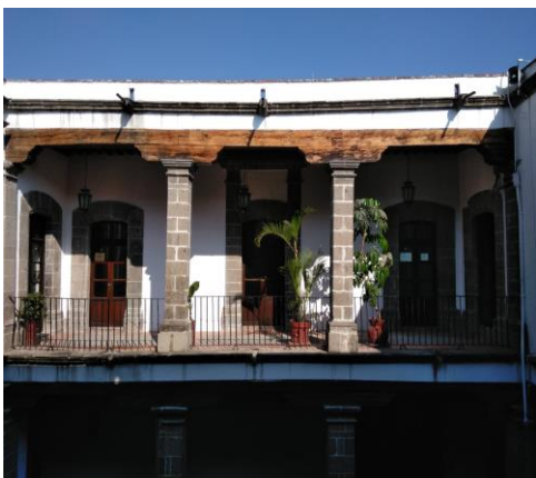
Figura 56 correspondiente a la zona restaurada en la segunda fase de restauración correspondiente a la planta alta del primer patio del inmueble. Fuente perteneciente al archivo fotográfico de Jessica Mendoza (2021).
