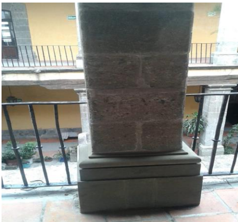
Figura 40 correspondiente a uno de las pilastras del inmueble. Se encuentra en la planta alta del primer patio. Fuente perteneciente al archivo fotográfico de Jessica Mendoza (2020).
