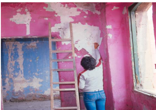
Figura 33 se puede observar cómo se está quitando la pintura de cuando el inmueble era utilizado como Casa habitación. Fuente perteneciente al archivo fotográfico de Gilda Cano (1987).
