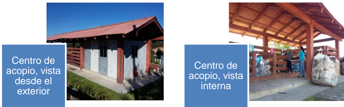
Figura 82. Centro de acopio de Mazamitla, Jalisco. Fuente: Sistema Intermunicipal de Manejo de Residuos Sureste.
