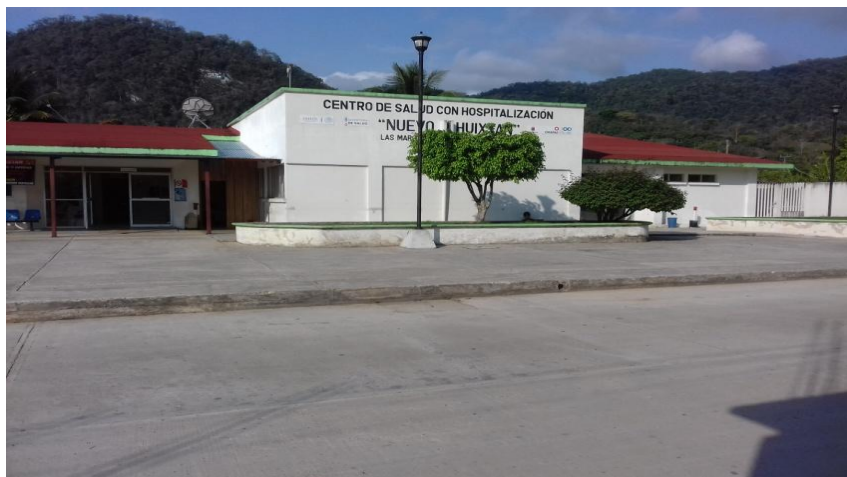
Centro de Salud con hospitalización en Nuevo Huixtán.
