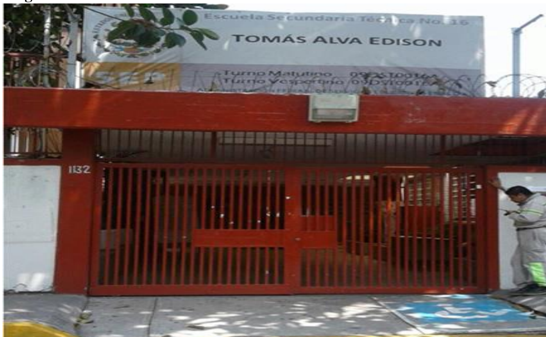
Imagen 3. Fachada de la Escuela Secundaria Técnica No.16 “Tomás Alva Edison”.
