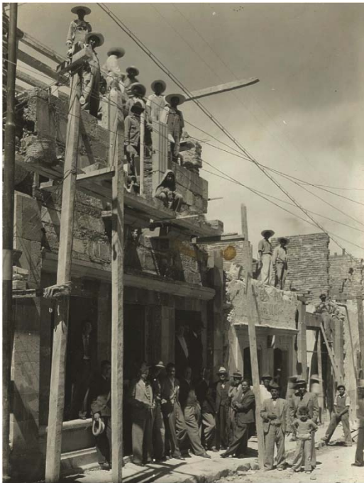
"La Casa del Judío" durante su construcción
