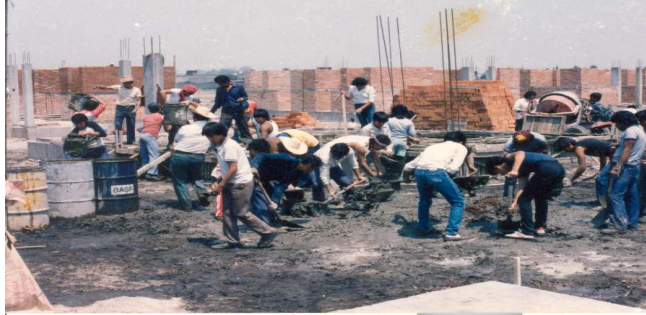
Trabajos en la cooperativa USCOVI.
